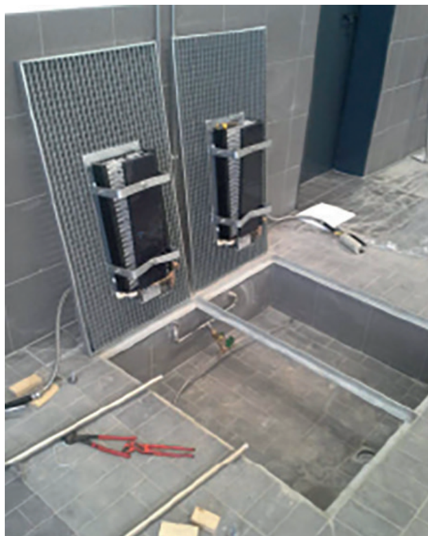
Construction de l'arbre d'une installation double
